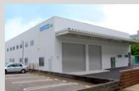
第二生産技術研究棟
