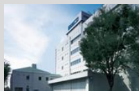
生産技術研究棟
