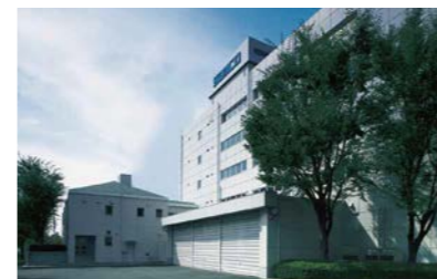
生産技術研究棟
