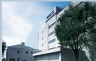
生産技術研究棟
