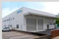
第二生産技術研究棟
