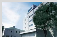
生産技術研究棟
