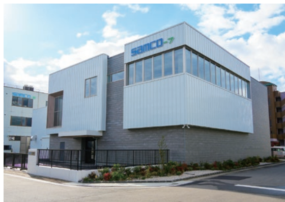
建設中の『先端技術開発棟』の様子 2024年12月9日時点
